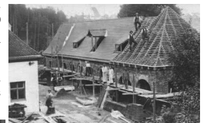
Das heute noch stehende Handwerkerhaus im Tal während des Baus 1914 links das Kesselhaus des Waschhauses
