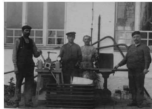
Spengler bei der Montage der Zentralheizung (ca. 1910)
